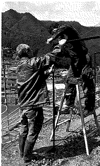
獣害対策防除ネットの設置中！
